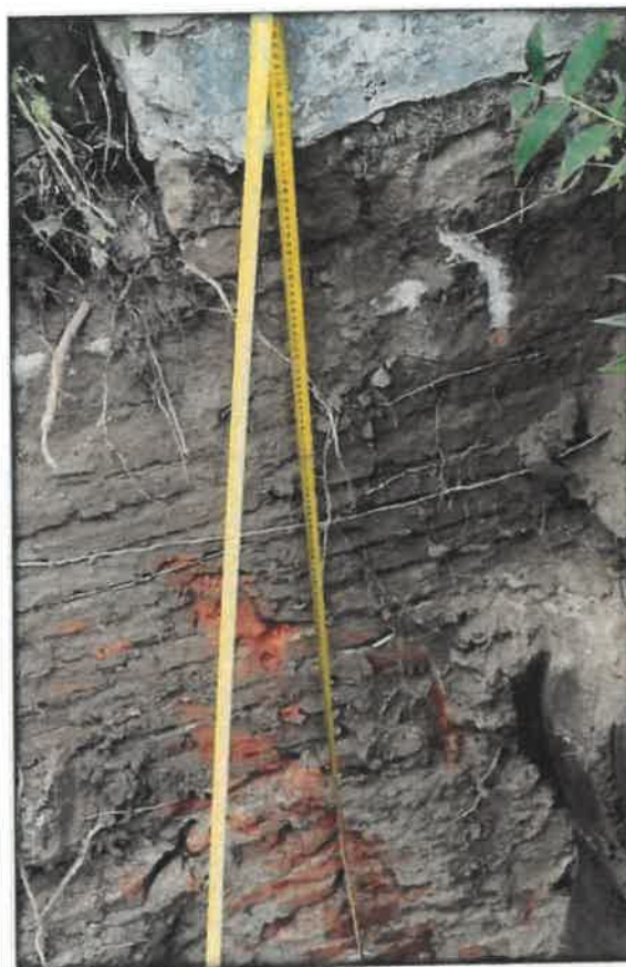
Fig. 2 - Dezvelire de fundație corp C2
