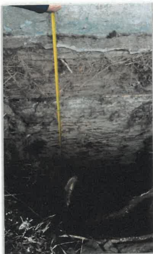
Fig. 1 - Dezvelire de fundație corp C1
